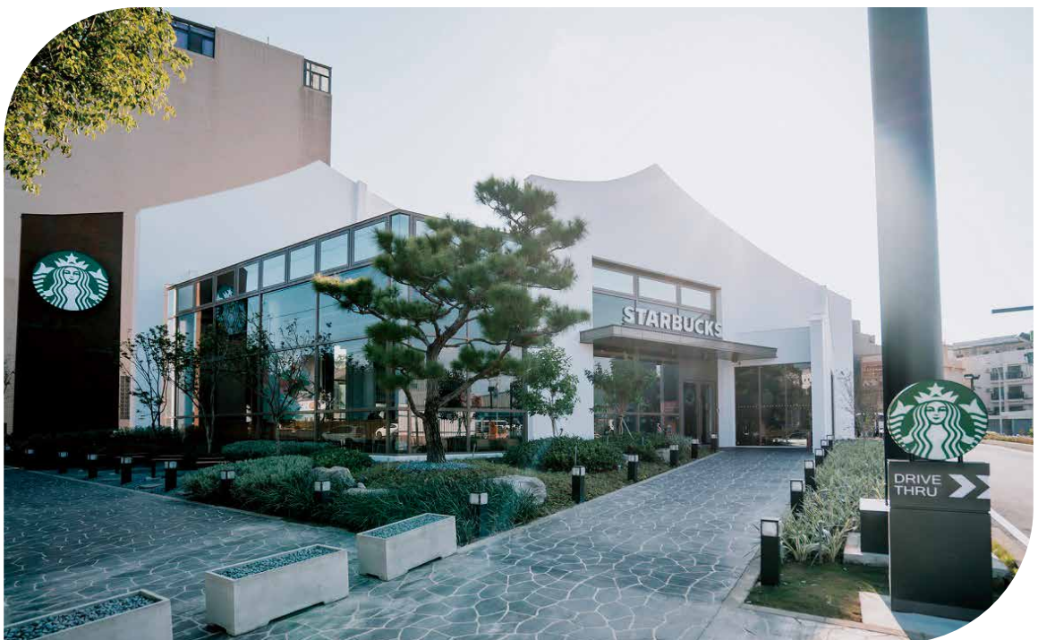
台灣首家 Greener Store 認證 (水循環系統、充電樁等) - 星巴克沙鹿北勢門市
