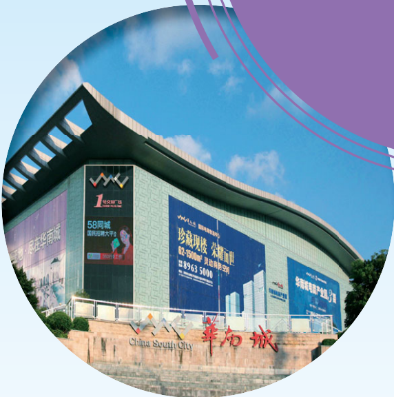
Plaza 1 in CSC Nanchang 於南昌華南城的1號交易廣場
