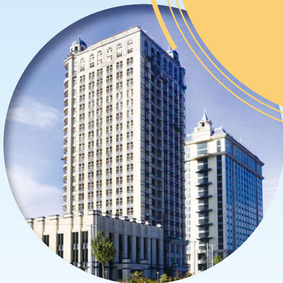
Multi-purpose properties in CSC Harbin 於哈爾濱華南城的多功能物業
