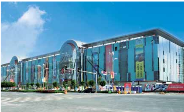
The logistics trade center under construction at CSC Nanning 在建中的南寧華南城物流交易中心
