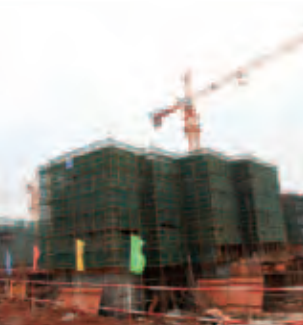
Residential Facilities under Construction 在建中的住宅設施
