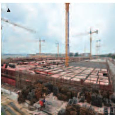
▲ Trade Centers under Construction 在建中的交易中心
