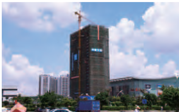
The new office tower under construction 在建中的新寫字樓
