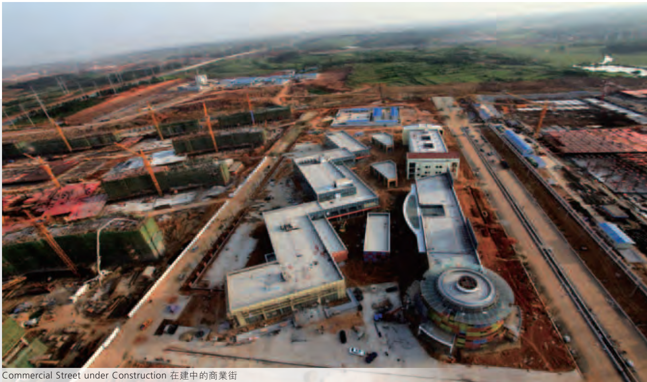
Commercial Street under Construction 在建中的商業街
