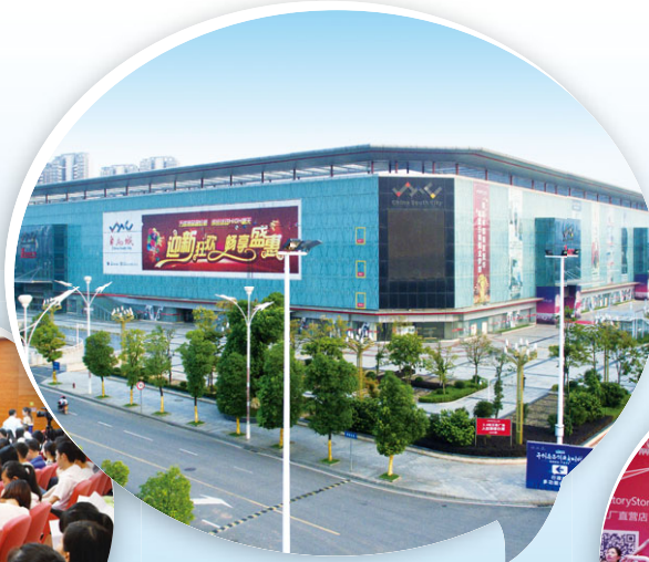
Trade center plaza 1 in CSC Nanchang 南昌華南城一號交易廣場
