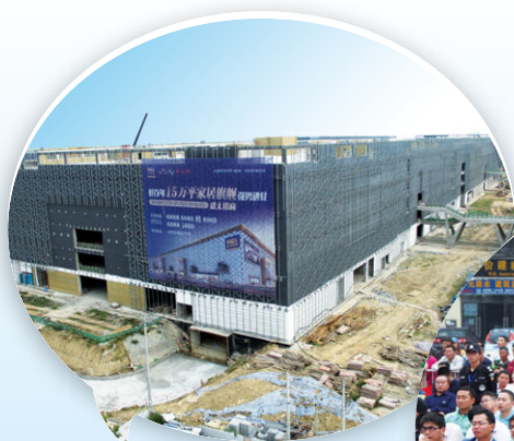
CSC Hefei under construction 在建中的合肥華南城
