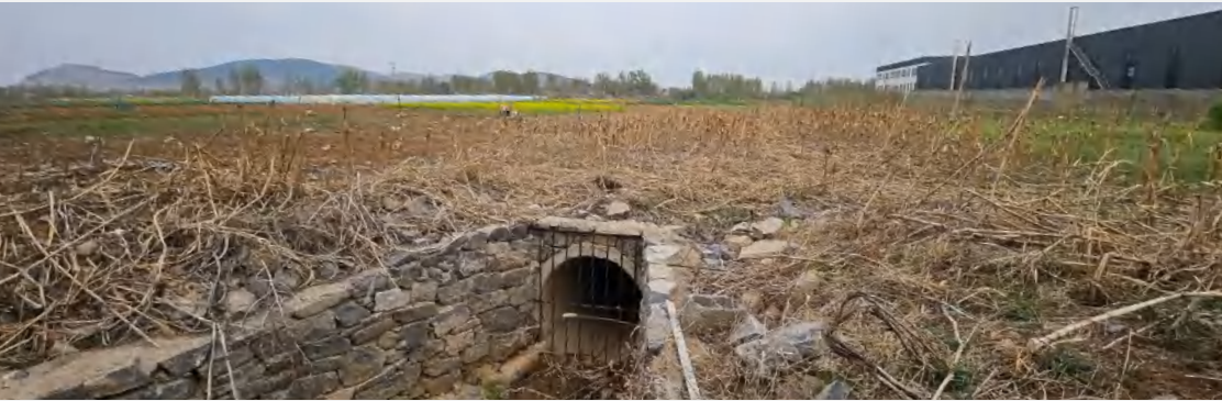
临沂牧场捐赠支持修建棠林村排水沟
